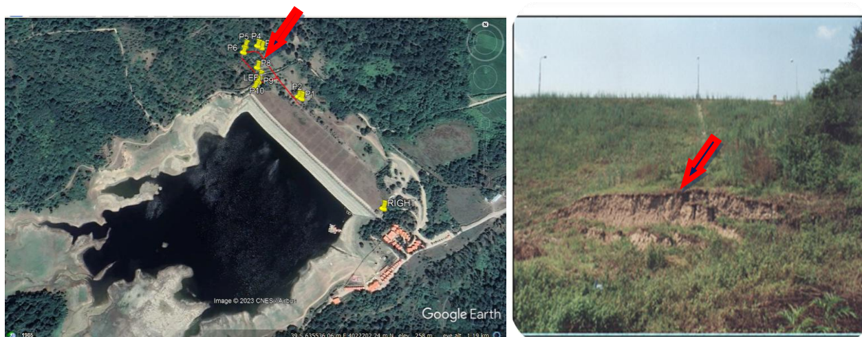
شکل ۱: رانش زمین در پایین دست تکیه گاه چپ و لغزش سطحی در پنجه سد
