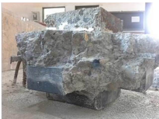
شکل ۱۳: وضعیت گسیختگی ایجاد شده در اطراف کلید برشی در دال دوم
