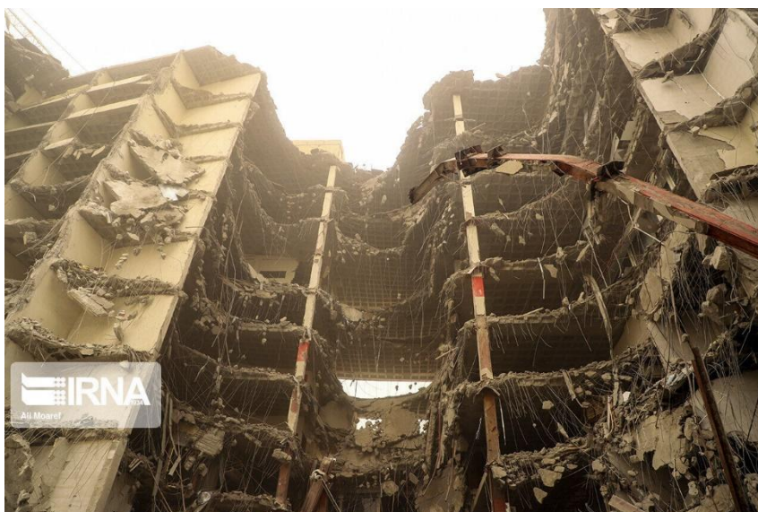
شکل ۱: نمایی از ساختمان فروریخته‌ی متروپل آبادان [۱۶]
