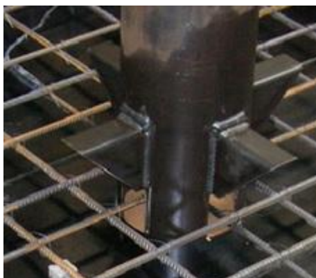
شکل ۳: عبور آرماتورها از میان ستون در روش بررسی شده توسط یان و وانگ [۲۸]
