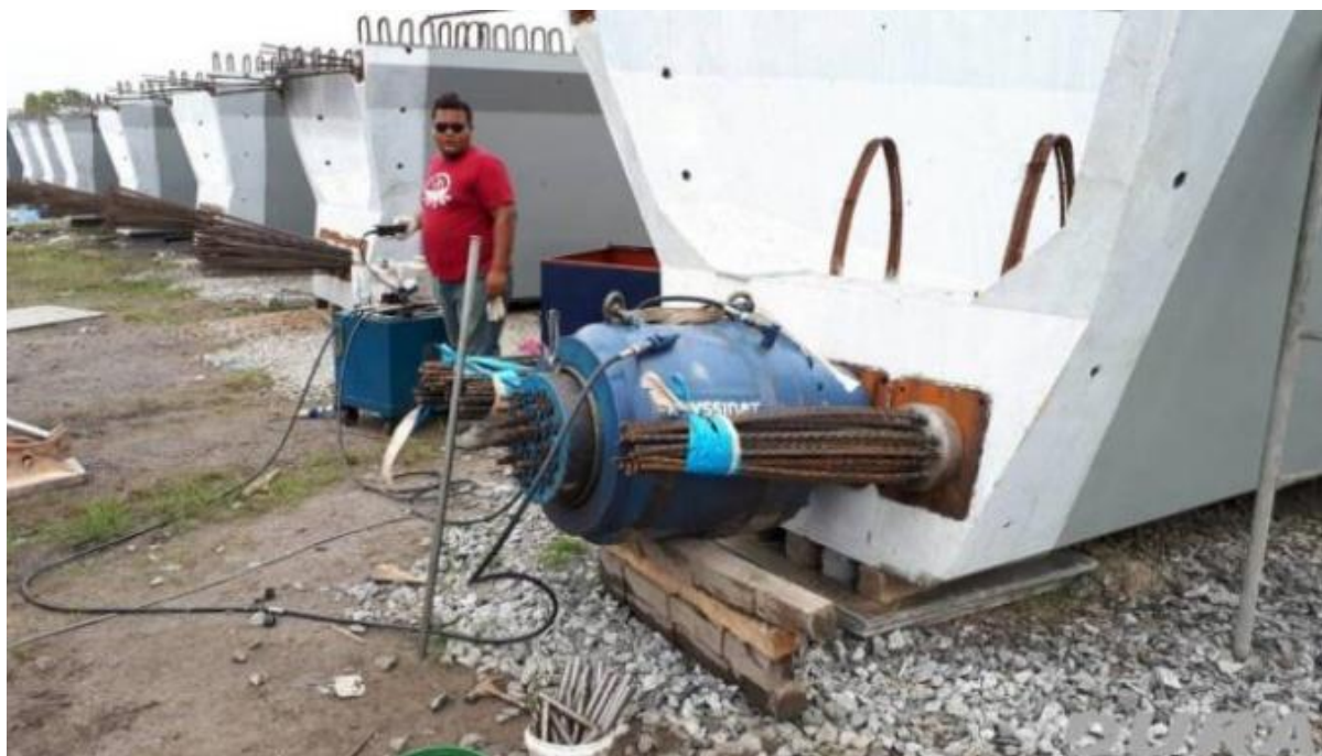
شکل ۱۴- استفاده از جک هیدرولیکی برای ایجاد نیروی پیش تنیدگی در کابل‌ها [۳۲].
