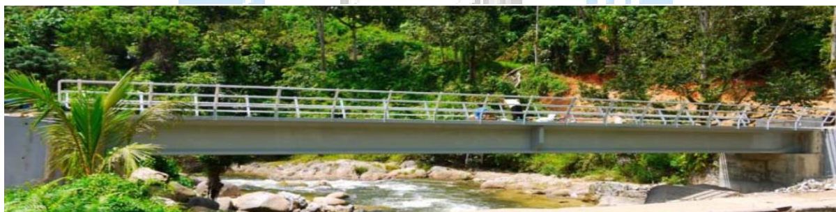
شکل ۲۴ - استفاده از بتن فوق توانمند برای اتصال بین دو تیر ۲۵ متری پیش ساخته T شکل [۱۳].
