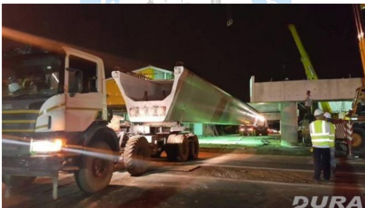
شکل ۱۵- تیر دهانه ۳۸ متری پس از تزریق دوغاب در غلاف‌ها و آمده قرار گیری روی پایه‌های پل [۳۲].
