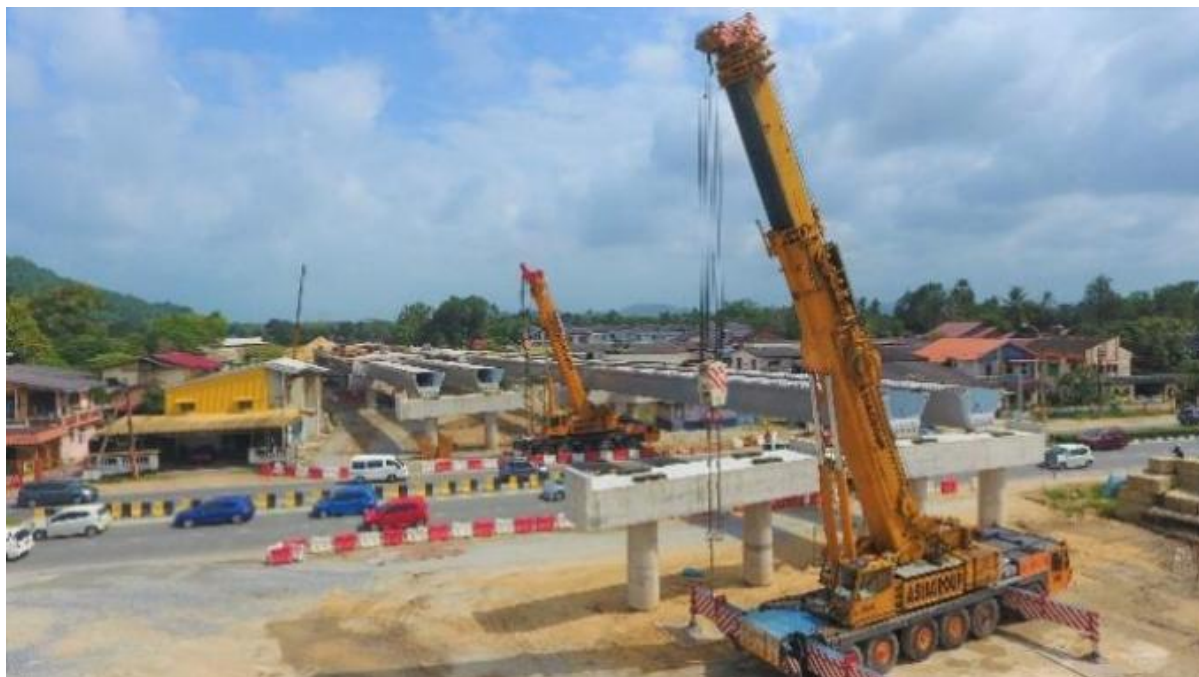
شکل ۱۶- انتقال تیر دهانه‌ی ۳۸ متری بر روی پایه پل با استفاده از دو جرثقیل ۱۶۰ تنی [۳۲].
