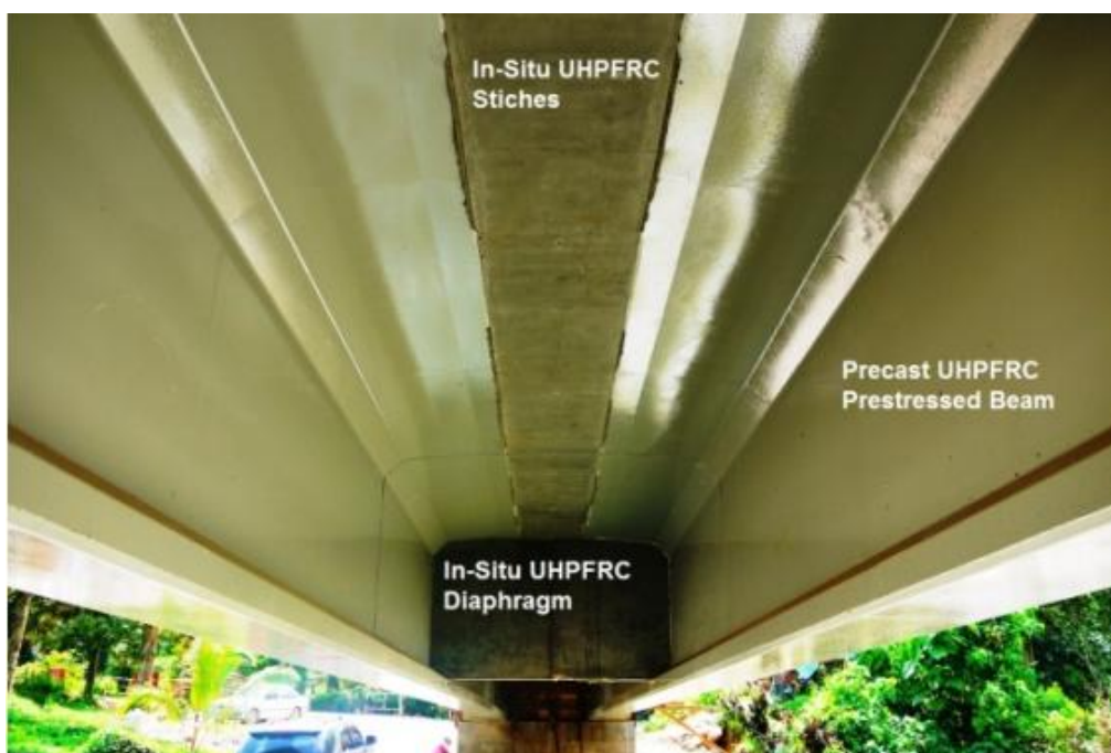
شکل ۲۴ - استفاده از بتن فوق توانمند برای اتصال بین دو تیر ۲۵ متری پیش ساخته T شکل [۱۳].
