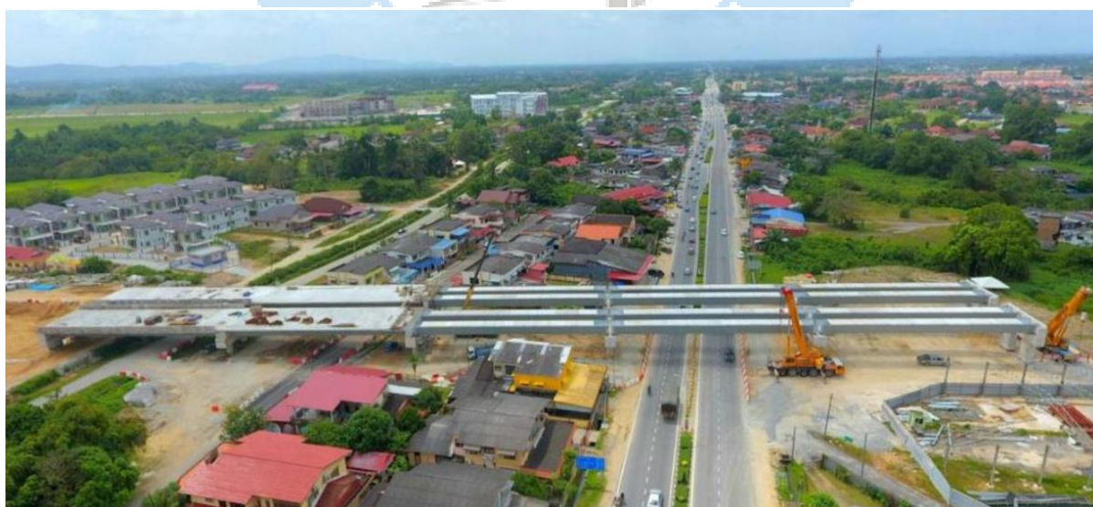
شکل ۵ - نمایی از پل KT-BypassST3 [۳۲].
