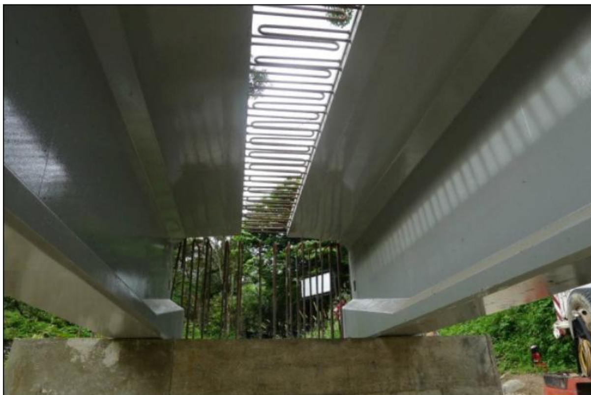
شکل ۲۲ - آماده شدن تیرهای ۲۵ متری برای اجرای تکیه گاه و اتصال بین آن‌ها [۱۳].
