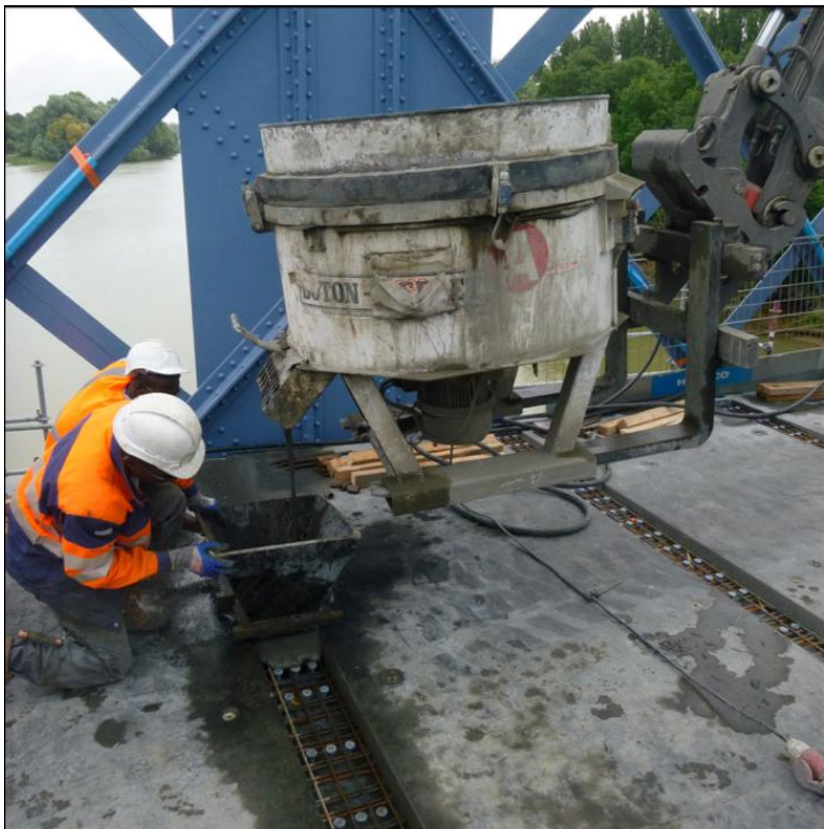
شکل ۲۸ - استفاده از بتن فوق توانمند برای اتصال قطعات پیش ساخته به یکدیگر [۳۳].
