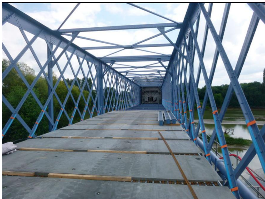
شکل ۲۷ - قرارگیری قطعات پیش ساخته بتن فوق توانمند در طول پل برای اجرای عرشه جدید [۳۳].
