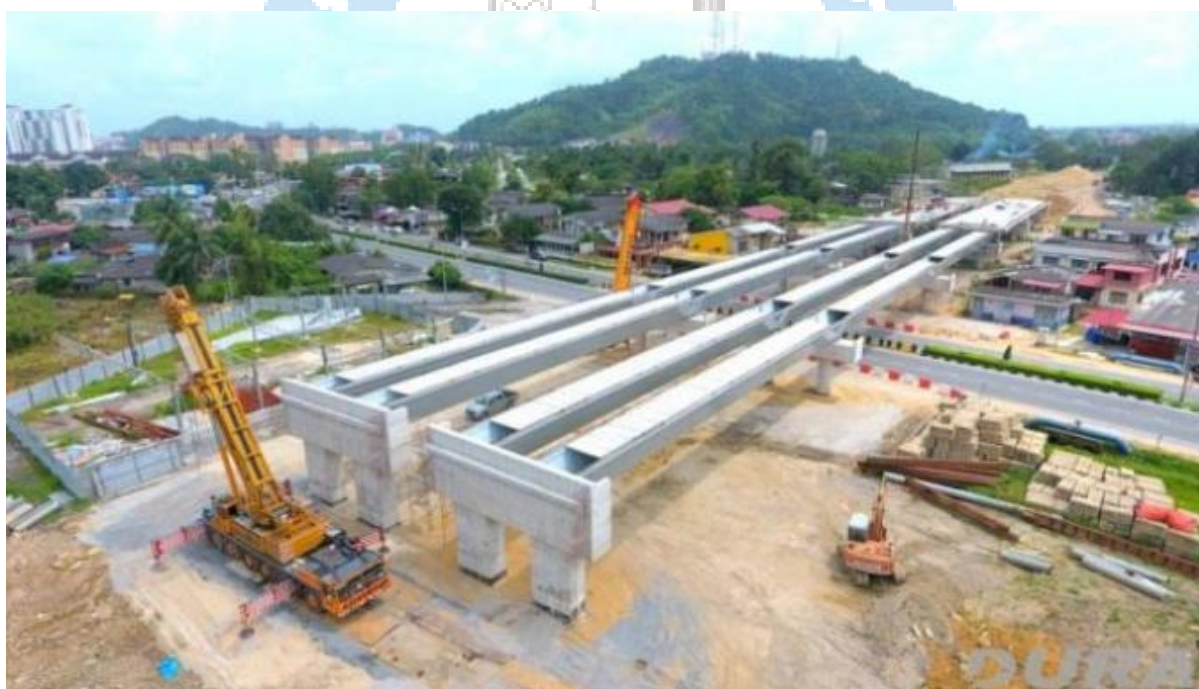
شکل ۱۷ - پایان عملیات انتقال قطعات پیش ساخته و پیش تنیده بر روی پایه‌های پل [۳۲].
