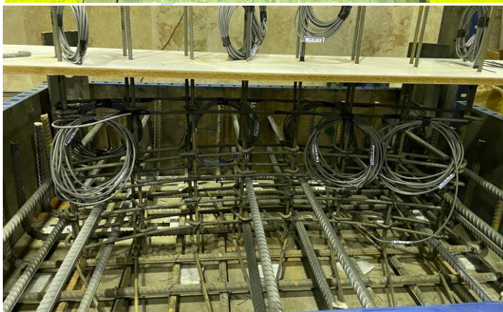
(۳) وضعیت قرارگیری میل‌مهاری در پی نمونه
