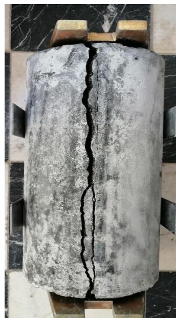
شکل ۱۰: گسیختگی نمونه بتن سبک کنترل بعد از اعمال بار کششی
