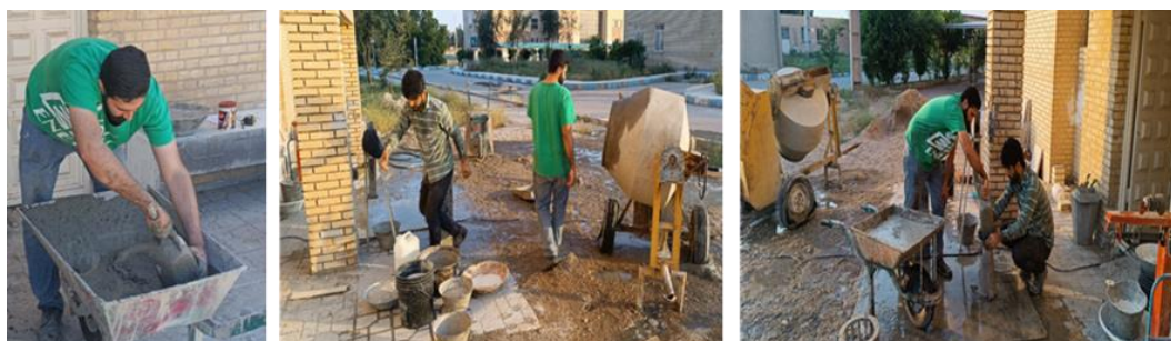
شکل ۱۵: ساخت بتن خودتراکم با اضافه نمودن مصالح در پن میکسر
