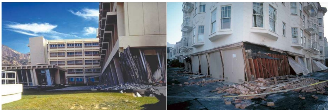
شکل ۱: مثال‌هایی از تشکیل مفصل پلاستیک در ستون و ایجاد طبقه نرم در طبقه همکف بعد از وقوع زلزله [۱]
