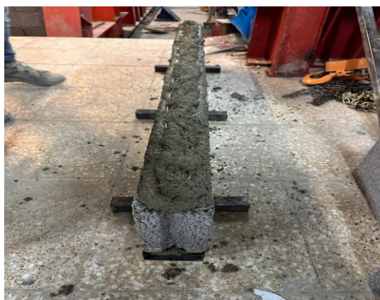
شکل ۴: نحوه ساخت رج های بلوکی و جانمایی ناودانی های فوقانی و تحتانی
