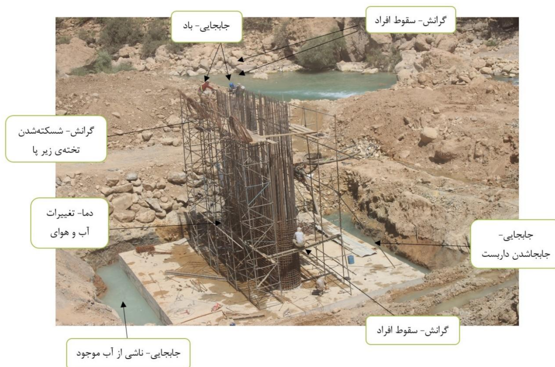
شکل ۱: یک نمونه از تصاویر منتخب برای ارزیابی توانایی تشخیص خطر توسط کارگران
