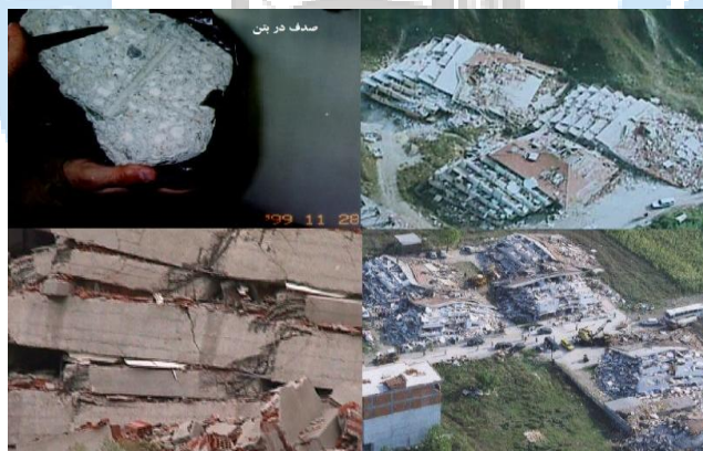
شکل ۱: خرابی گسترده ساختمان‌های مسکونی قاب خمشی بتن مسلح در زلزله ۱۹۹۹ کوجانلی ترکیه ناشی از ضعف بتن با ۱۸ هزار کشته [۲۰].
