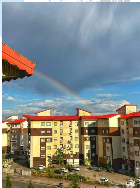
شکل ۵: پروژه انبوه سازی مسکن مهر شهر رشت
