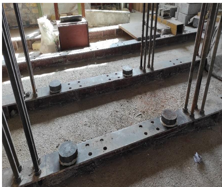
شکل ۷: آماده‌سازی تکیه‌گاه‌های نمونه
