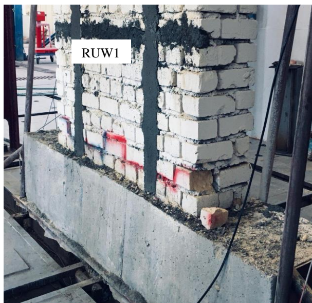
شکل ۱۵: در نسبت جابجایی 0/461\% خرد شدن آجر پاشنه.
