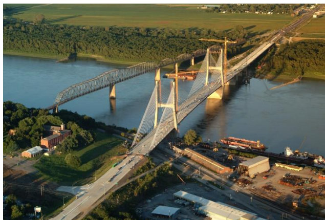
شکل ۱: نمایی از پل کابلی بیل امرسون در آمریکا [۲۰ و ۲۳]
