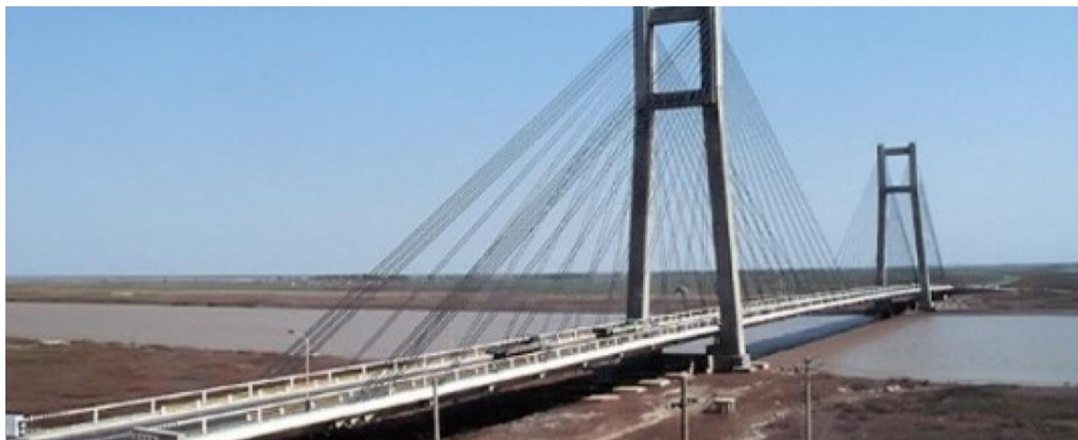
شکل ۲: نمای کلی از پل یانگ
