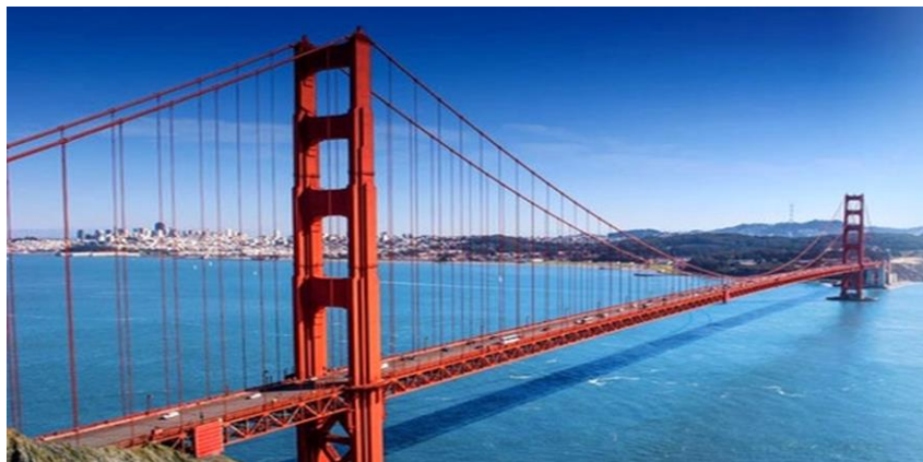
شکل ۱. پل معلق گلدن گیت
