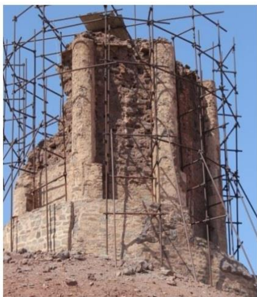
شکل ۲: وضعیت برج در حال حاضر
