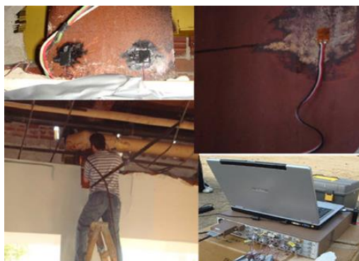
شکل ۱۳: نصب کرنش سنج بر روی ستون ها و تیرهای اطراف ستون های حذف شده [۲۳]
