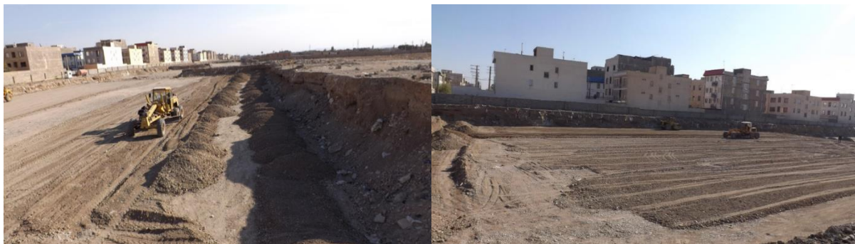
شکل ۸: دیو مصالح و رگلاژ مصالح - بلوک ۲
