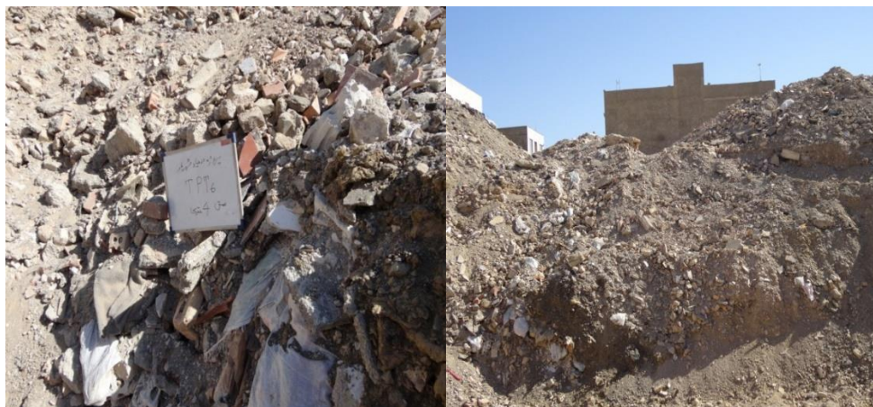
شکل ۵: عملیات حفاری ترانشه‌ها و وضعیت لایه‌های خاک موجود [۱۵]
