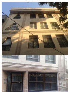
شکل ۳: ساختمان مسکونی ۴ طبقه واقع در تهران - ایران
