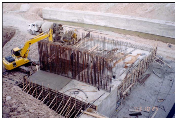
شکل ۱: نمونه‌ای از بتن‌ریزی در پروژه سد یامچی
