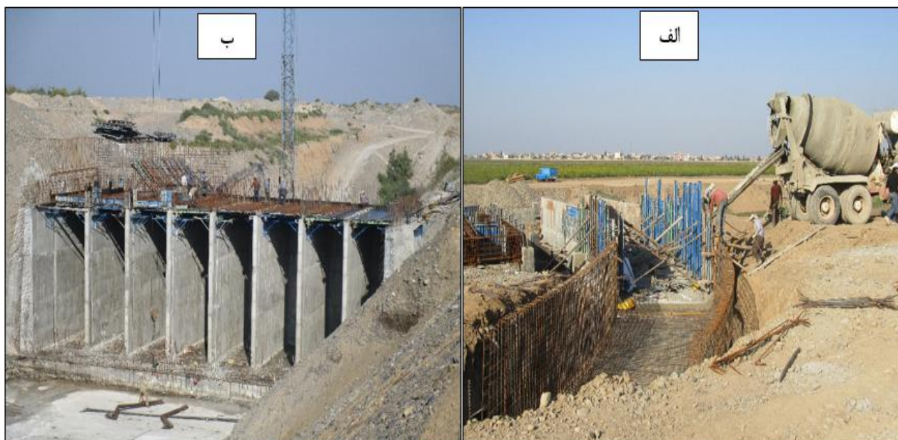
شکل ۲: نمونه ای از بتن ریزی در شبکه آبیاری و زهکشی طرح پایاب خداآفرین: الف) قالب بندی و بتن ریزی فلوم. ب) قالب بندی و بتن ریزی ایستگاه پمپاژ
