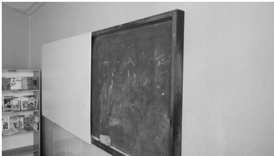
شکل ۴: نصب تخته‌سیاه مدرسه بر روی دیوار ال‌اس‌اف.
