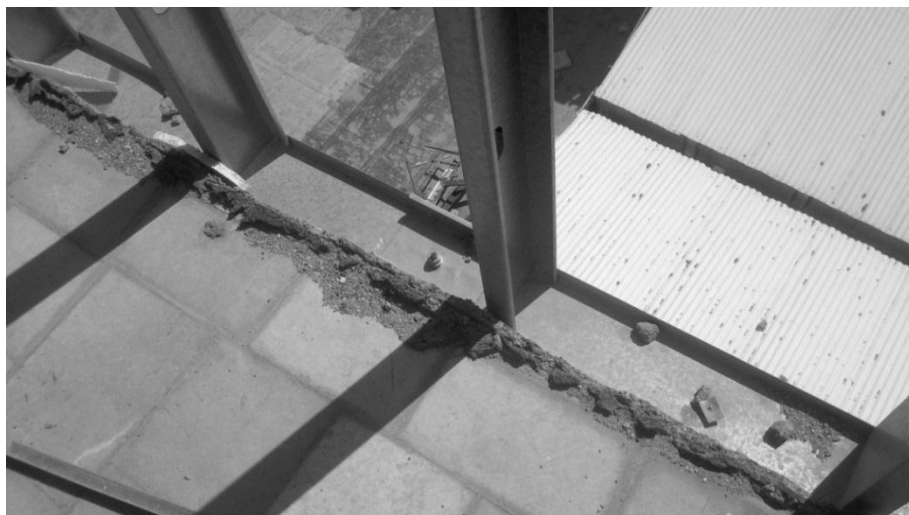
شکل ۱۱: تخریب عایق رطوبتی جهت اجرای اضافه طبقه.
