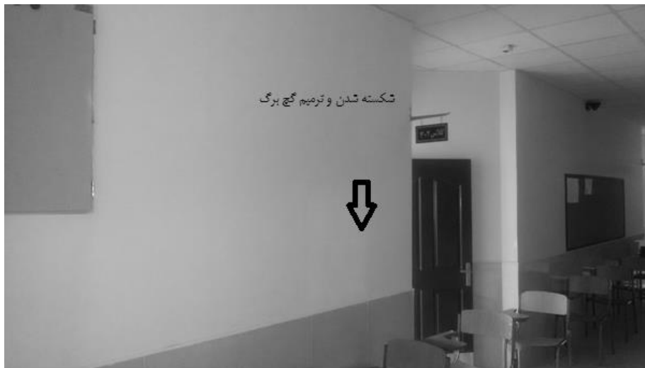
شکل ۵: شکسته شدن گچ برگ ها در اثر برخورد افراد.
