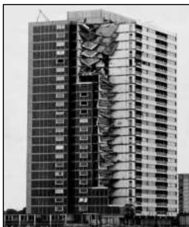
شکل ۱: فروریزش ساختمان رونان پوینت در سال ۱۹۶۸ [۱].
