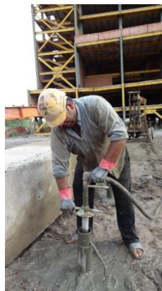
شکل ۹: عملیات تزریق در شمع پیچی.
