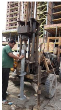
شکل ۷: اجرای شمع‌های پیچی پره دار.
