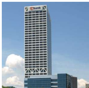
شکل ۱: نمای خارجی ساختمان فرست ویسکانسین ستر [1].
