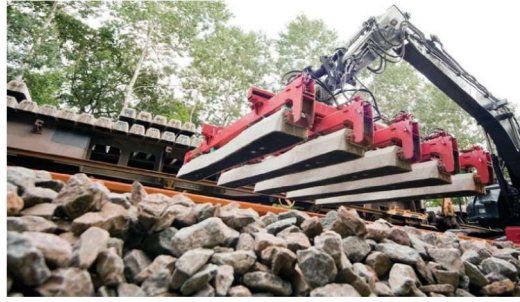
شکل ۳: جایگذاری تراورس‌های مجهز به پد زیر تراورس.
