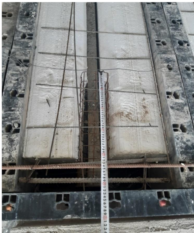
شکل ۹- نمونه دال با بلوک فوم و شبکه سیمی جوش شده در انتها
