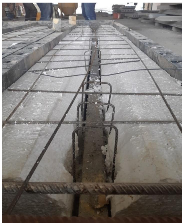
شکل ۱۰- نمونه تیرچه با بلوک فوم و خرک‌های برشی
