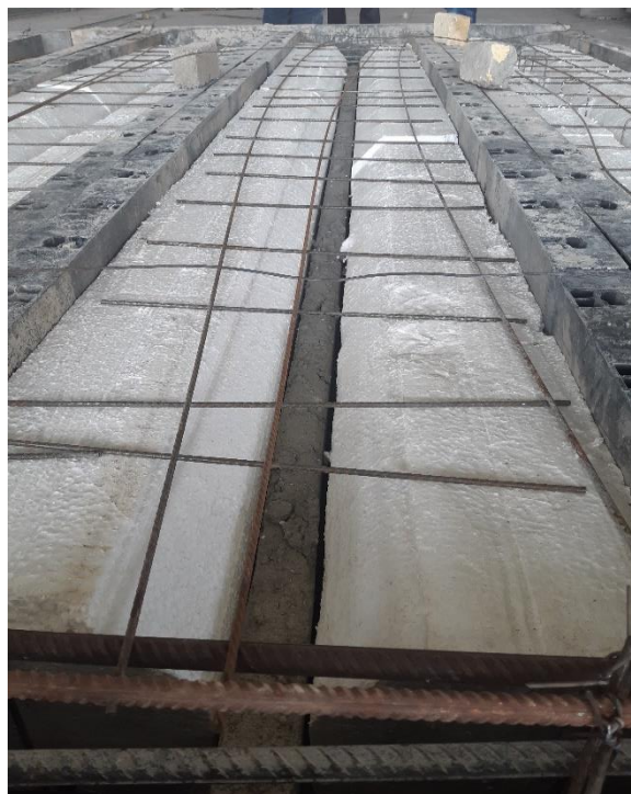
شکل ۷- نمونه تیرچه با بلوک فوم و بدون تقویت برشی
