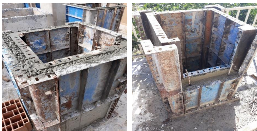
شکل ۸: بتن‌ریزی دیواره مخازن
