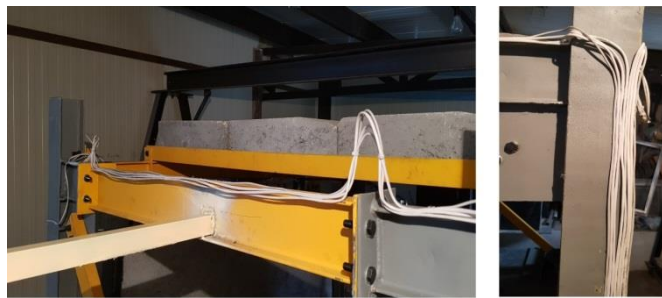
شکل ۱۰: کابل کشی از تجهیزات اندازه‌گیری به دستگاه ثبت اطلاعات
