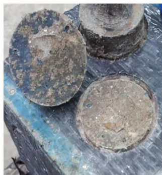
ب) نمونه بدون پوشش محافظ، گسیختگی در سطح بالایی بتن و ماتریس
