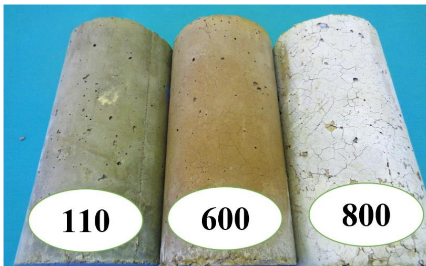
شکل ۱۴: تغییر رنگ و گسترش ترک‌ها بر اثر افزایش درجه حرارت بتن
