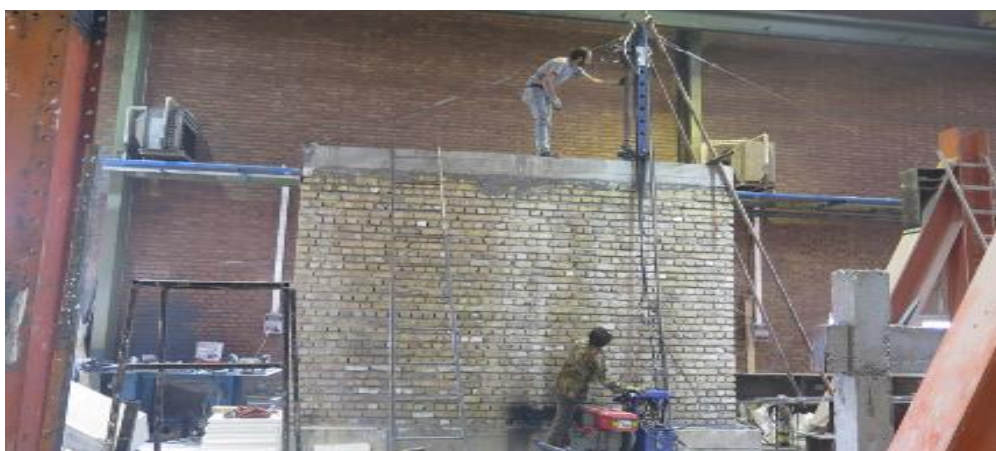
شکل ۳: عملیات حفر محل مغزه‌ها
