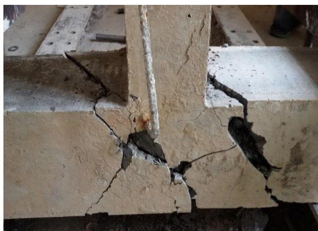
شکل ۹: حالت شکست پیچشی بتن با ۰/۷۵ درصد الیاف
