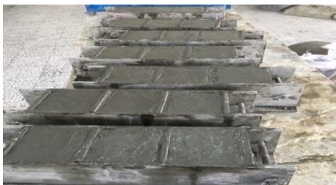
شکل ۴: بتن ریخته شده در قالب
