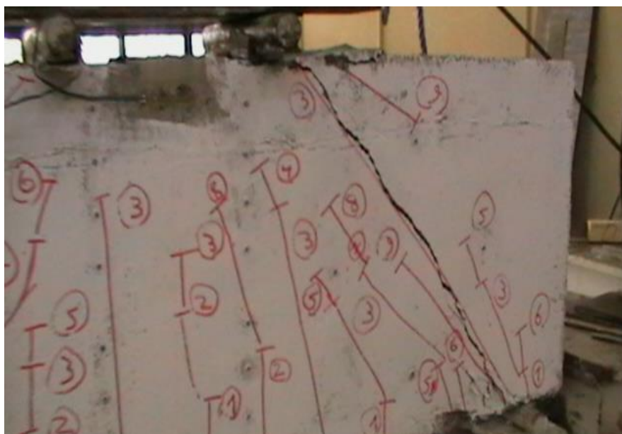
شکل ۷: نحوه ترک خوردگی و شکست تیر A-R
