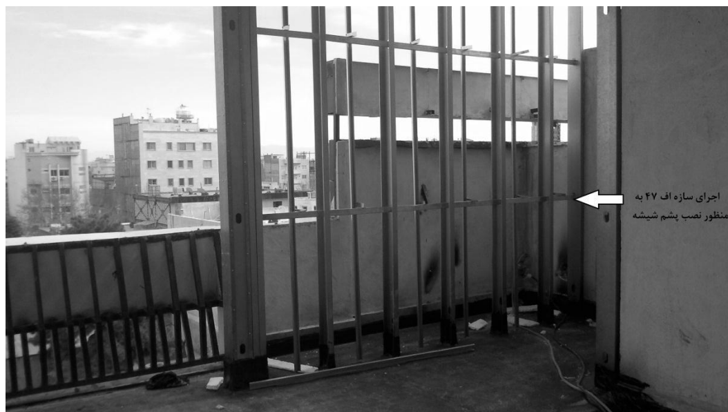
شکل ۵: اجرای تمامی استاداها در سیستم ال اس اف
