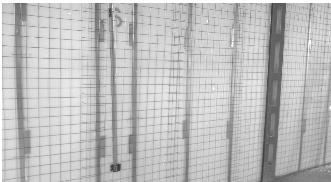
شکل ۴: دیوار متال فوم به همراه شبکه‌ی مش (آماده‌ی اجرای شات‌کریت)
