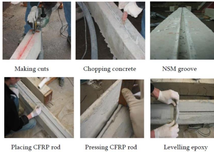
شکل ۱: مراحل کاشت آرماتورهای NSM در پوشش بتن.
