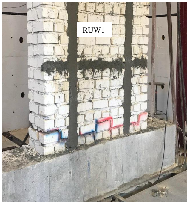
شکل ۱۴: در نسبت جابجایی 0/251\% ترک خوردن ستونک‌های قائم بتنی.
