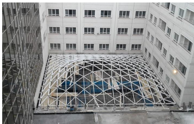
شکل ۲- سازه فضاکار فرم آزاد آتی سنتر مشهد، منبع: شرکت سازه‌های فضاکار افق نور
