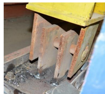
شکل شماره ۹: اتصال لولایی پای ستون
