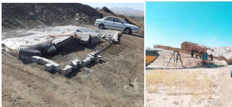
شکل ۲- الف) سنگدانه‌های بازیافتی کرمانشاه، ب) آماده‌سازی سنگدانه‌های بازیافتی با منشا مشخص
