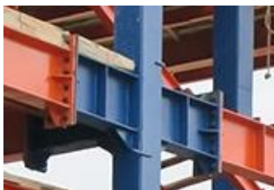
شکل ۱: سازه فلزی با ستون درختی.
