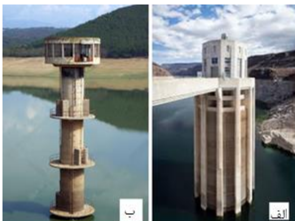
شکل ۱. الف) برج آبگیر با المان‌های قائم ب) برج آبگیر با المان‌های افقی
